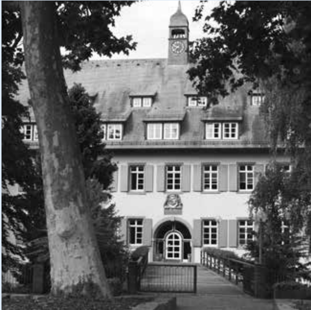
Das ehemalige Wasserschloss bietet ...
